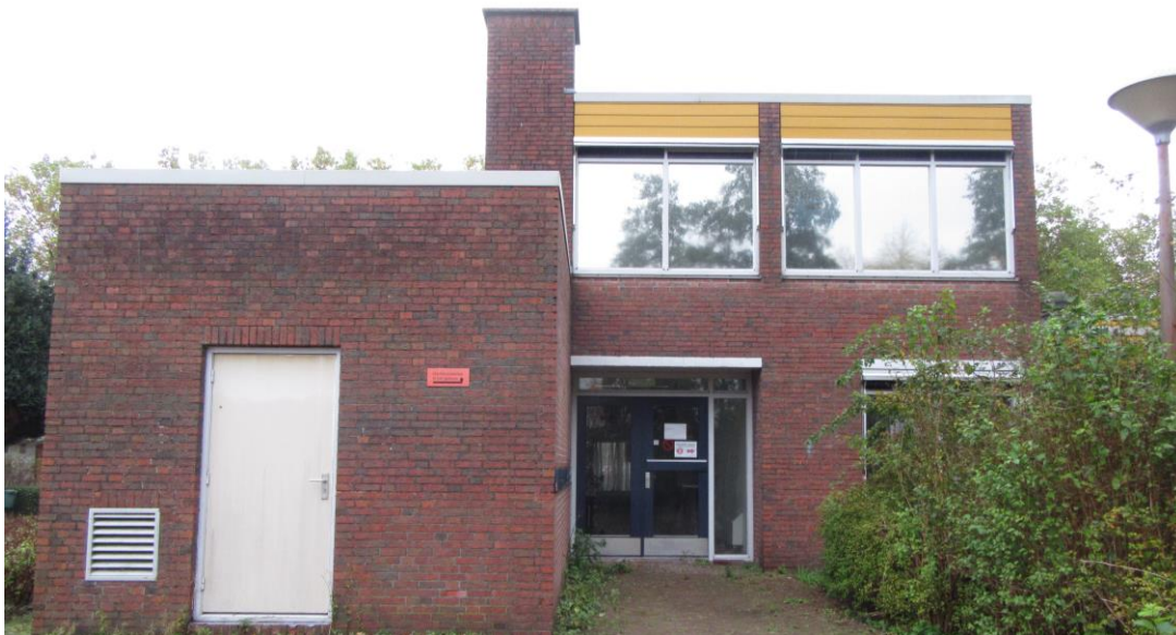
Figuur 2.9. Noorzijde kantoorpand (linker gedeelte).
