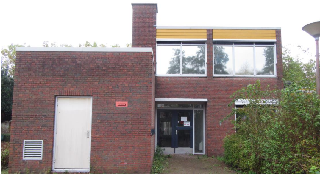
Figuur 9: Noorzijde kantoorpand (linker gedeelte)
