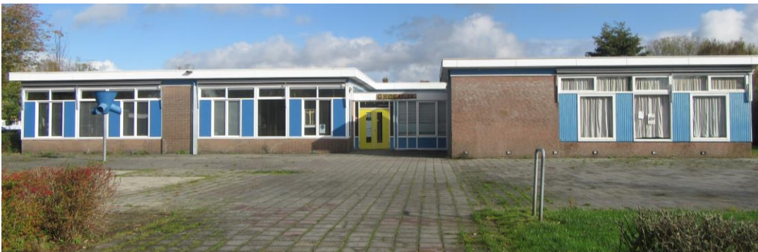
Figuur 18: Zuidwestzijde Vredeveltschool
