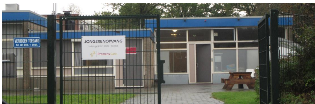
Figuur 2: Entree jongerenopvang (zuidzijde pand) met gedeelte van het entreeplein
