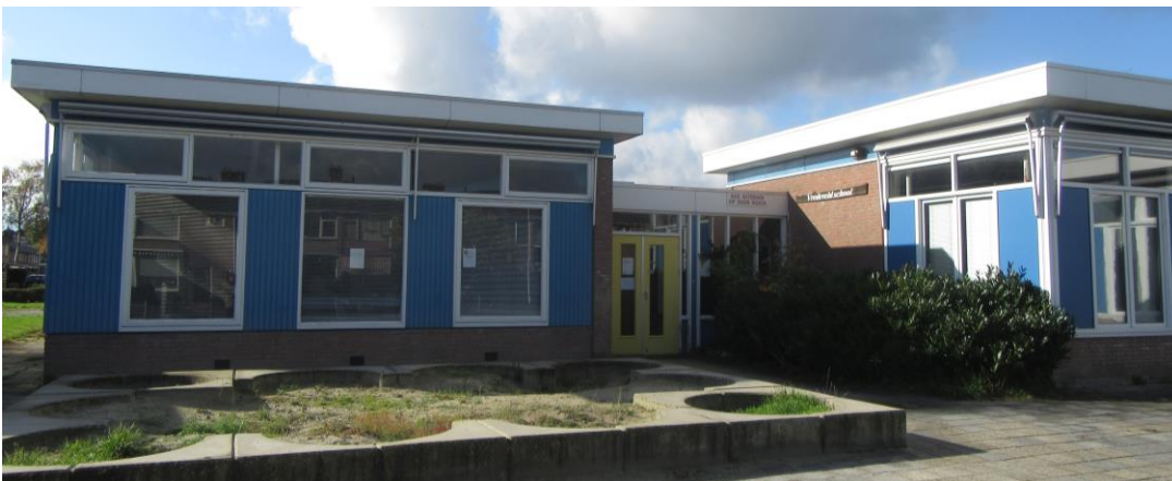
Figuur 19: Zuidoostzijde Vredeveltschool
