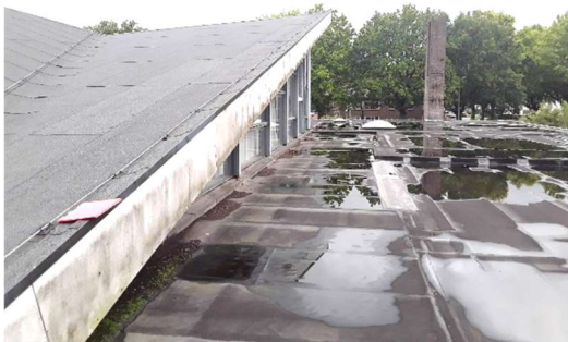
Foto 3 Platte en schuine delen van het dak
