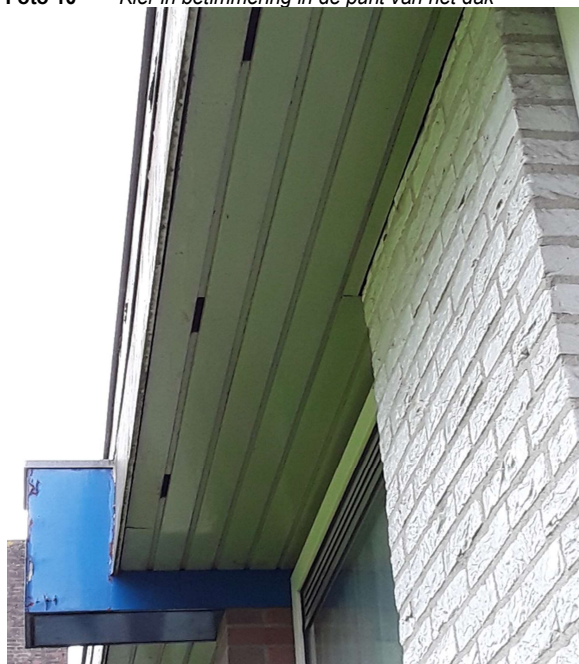
Foto 11 Kieren naar de dakruimtes
