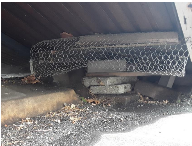
Foto 14 Voorbeeld van met gaas dichtgemaakte openingen op het dak tegen steenmarters
