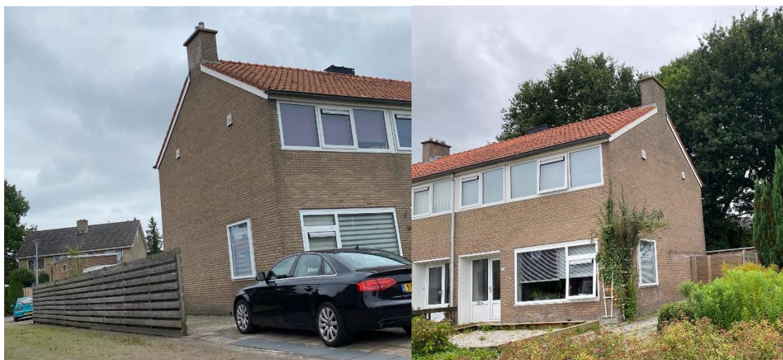
Figuur 10 Foto's opgehangen vleermuiskasten Echtenstraat 39 en Venestraat 229
