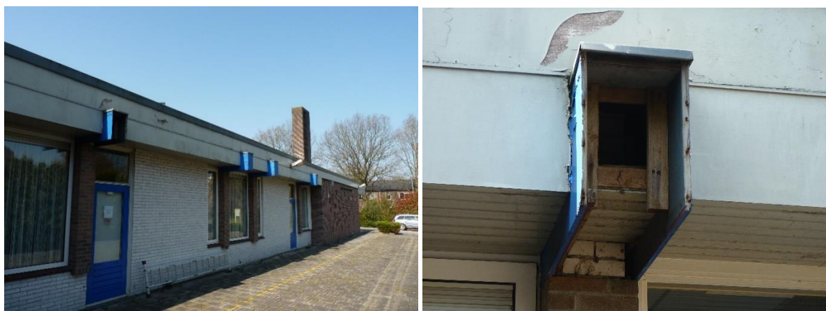
Foto 16 Grote opening in holle dakrand waar een plaatje is verwijderd (rechts)
