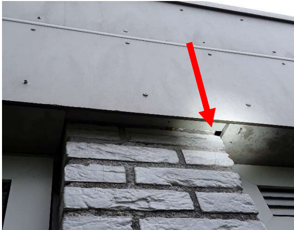
Foto 13 Voorbeelden van kieren in betimmering
