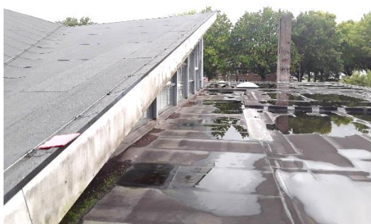
Foto 3 Platte en schuine delen van het dak
