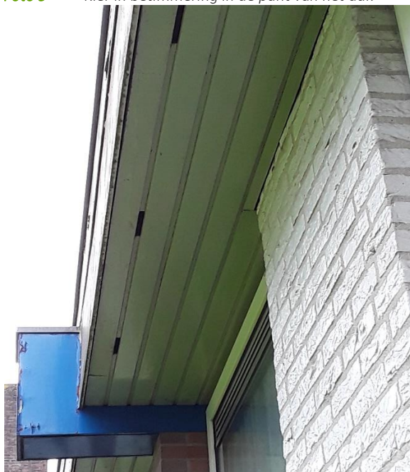
Foto 10 Kieren naar de dakruimtes
