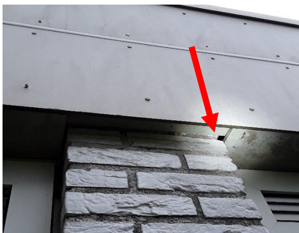
Foto 12 Voorbeelden van kieren in betimmering
