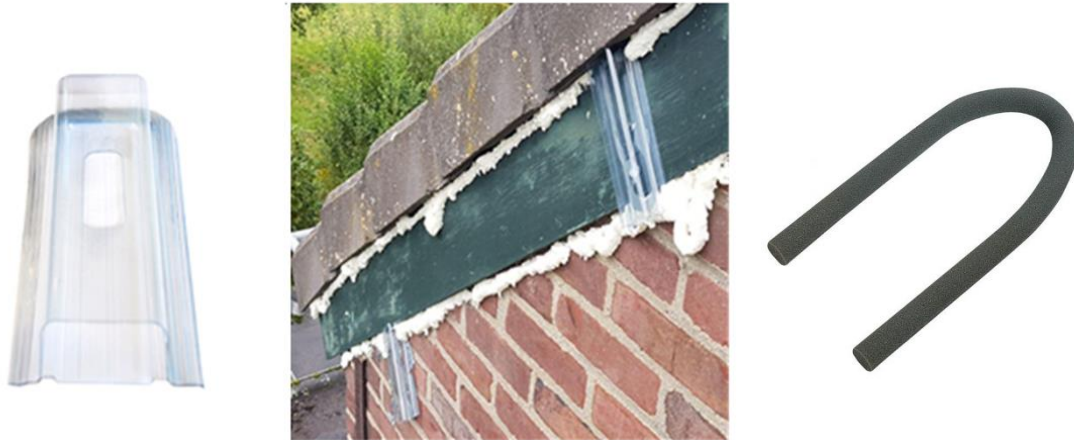
Figuur 3 Een exclusion flap (links) en geplaatste exclusion flaps bij kantpannen (midden en vulschuim (rechts). Vulschuim en flaps zijn verkrijgbaar bij unitura.nl
