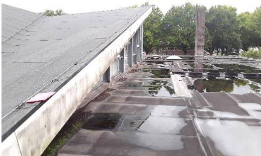
Foto 3 Platte en schuine delen van het dak
