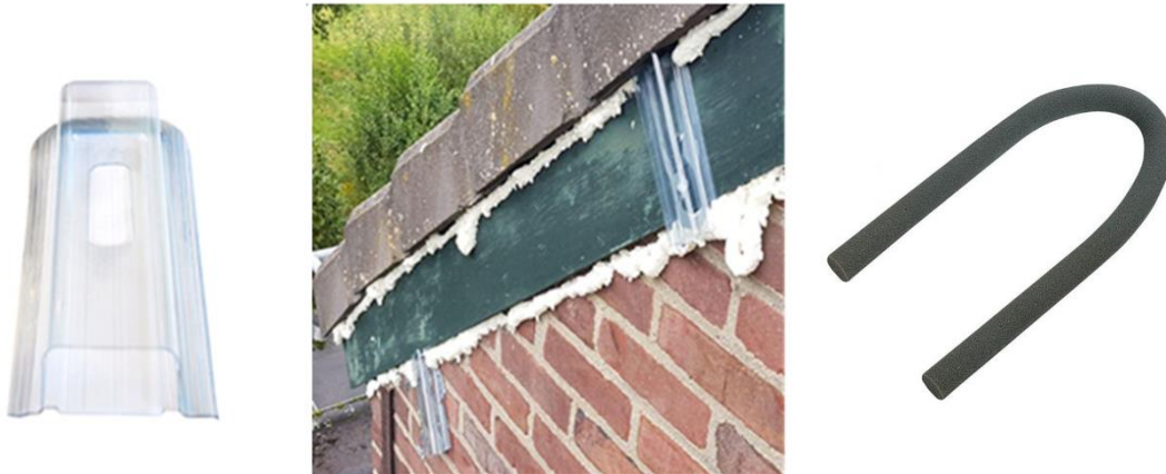
Figuur 17 Een exclusion flap (links) en geplaatste exclusion flaps bij kantpannen (midden en vulschuim (rechts). Vulschuim en flaps zijn verkrijgbaar bij unitura.nl
