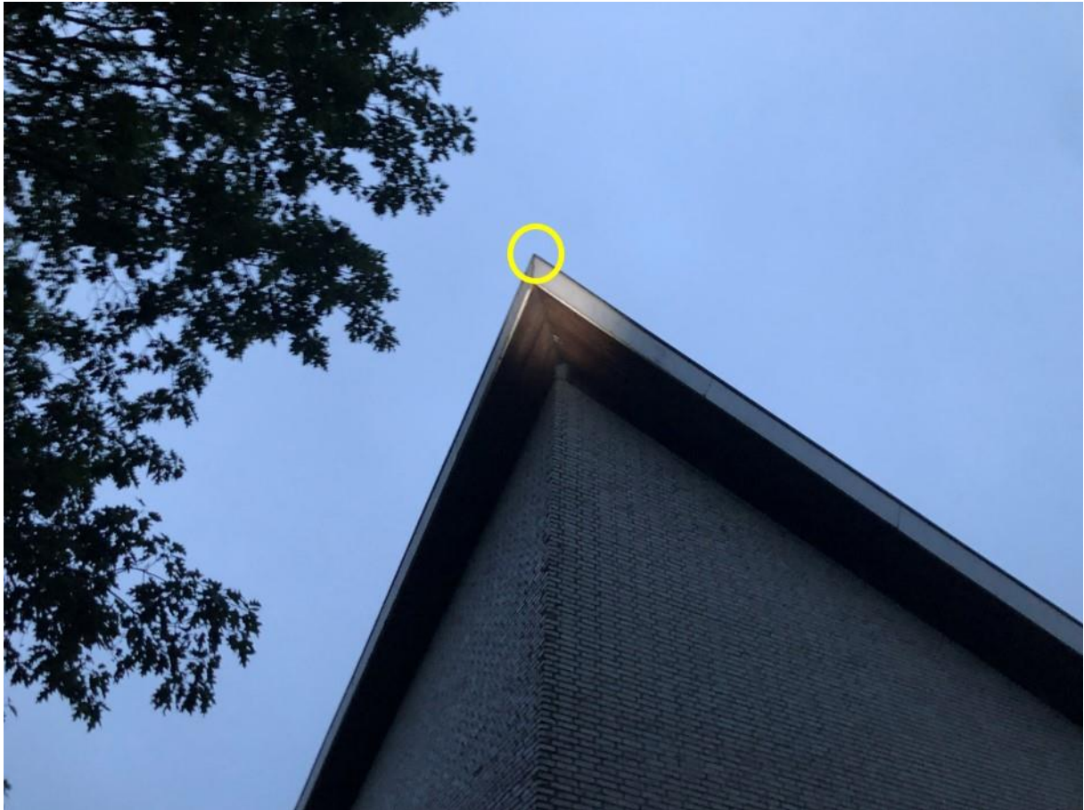
Foto 17 Punt van de Maranathakerk (gezien vanuit de achtertuin) waar een zomerverblijfplaats van één gewone dwergvleermuis is
