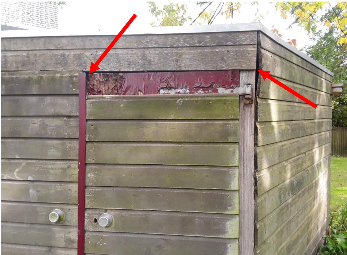
Foto 13 Hokje in de tuin, met kieren waardoor vleermuizen mogelijk naar binnen kunnen
