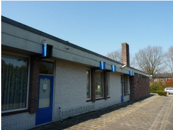
Foto 16 Grote opening in holle dakrand waar een plaatje is verwijderd (rechts)
