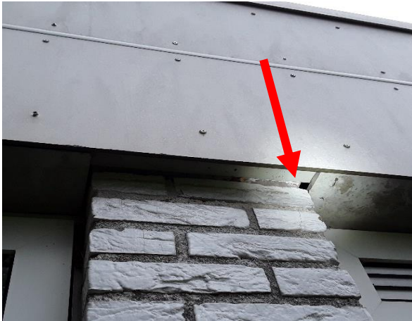
Foto 12 Voorbeelden van kieren in betimmering
