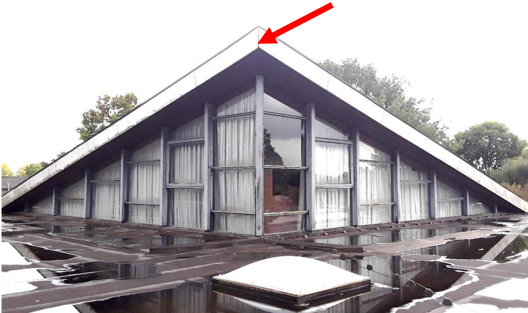
Foto 9 Kier in betimmering in de punt van het dak
