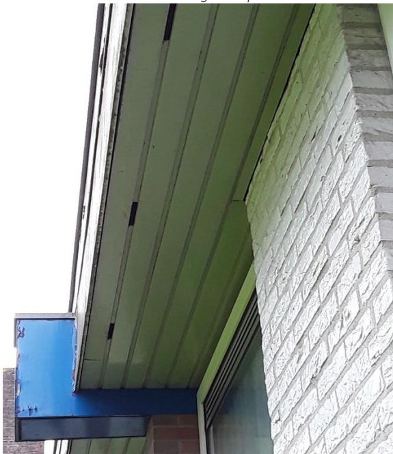
Foto 10 Kieren naar de dakruimtes
