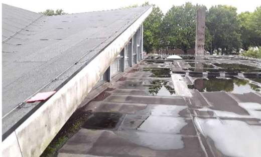
Foto 3 Platte en schuine delen van het dak
