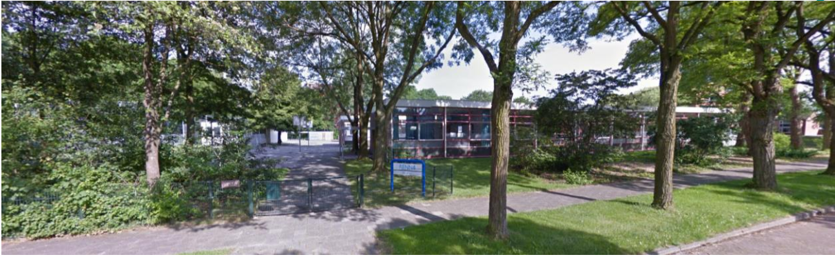
Figuur 2-3 Westzijde schoolgebouw Vivaldilaan 46 te Assen (Bron: GoogleMaps)
