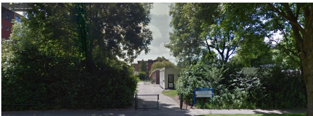
Figuur 2-4 Zuidzijde schoolgebouw Vivaldilaan 46 te Assen (Bron: GoogleMaps)
