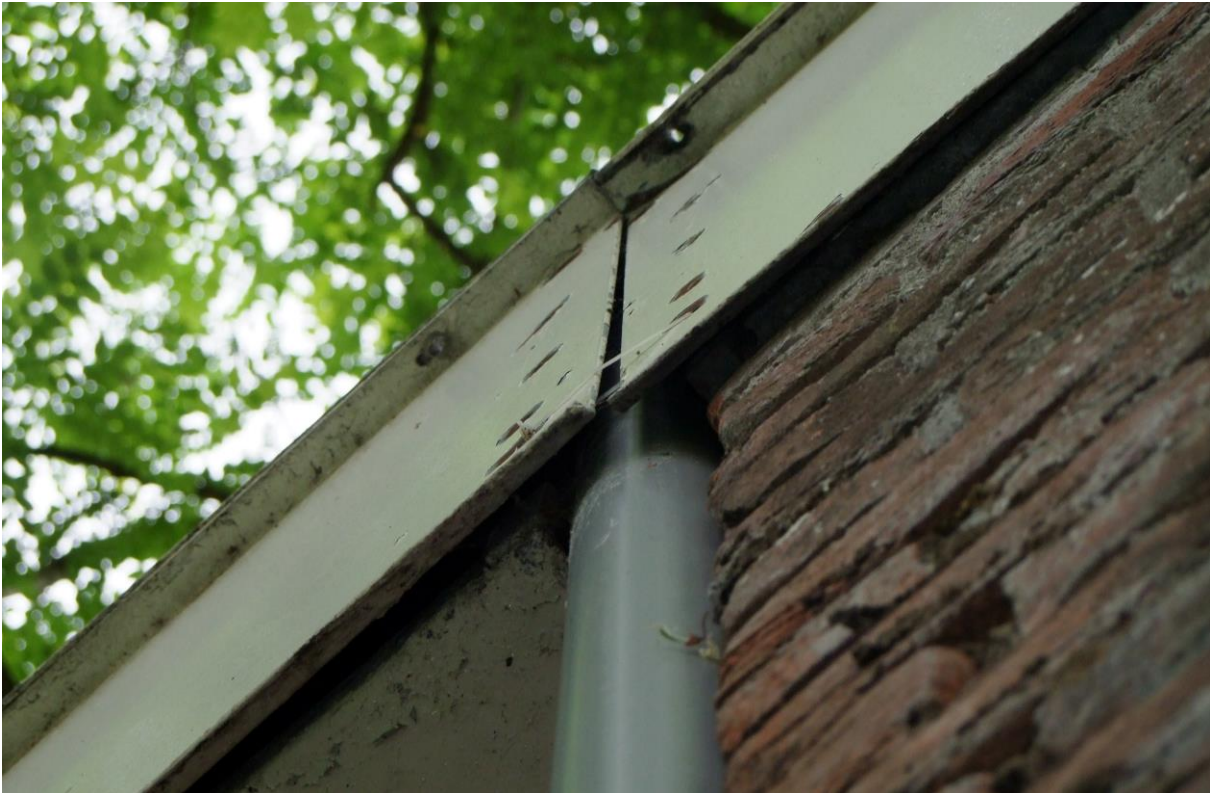
Figuur 5.1 potentiële verblijfplaats schoolpand voor gebouw bewonende vleermuizen
