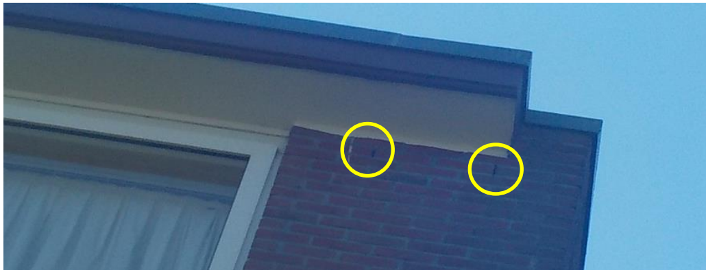
Figuur 10 Open stootvoegen waar de vleermuis in de spouwmuur kan komen.
