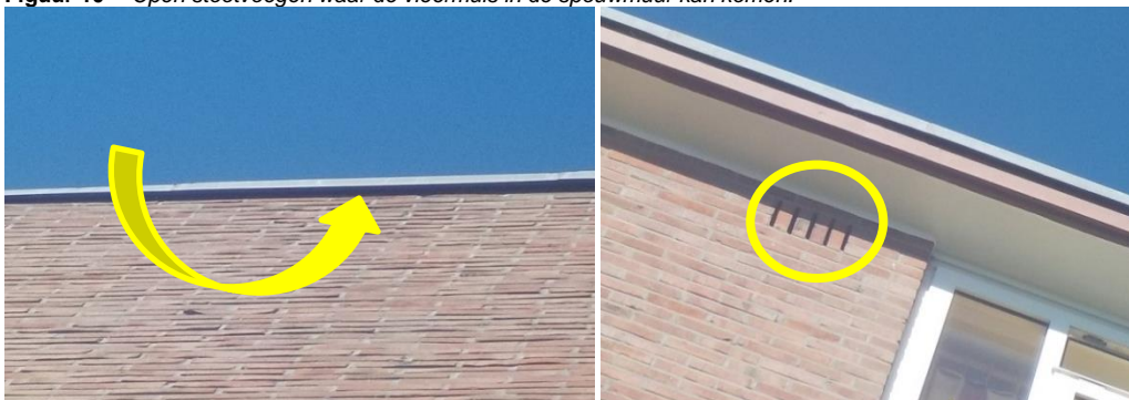
Figuur 11 (links) Ruimte tussen de aluminium daklijst geschikt voor verblijfplaats vleermuis (rechts) Ventilatiespleten met vrije aanvlugroute waar vleermuizen in de spouwmuur kunnen komen.
