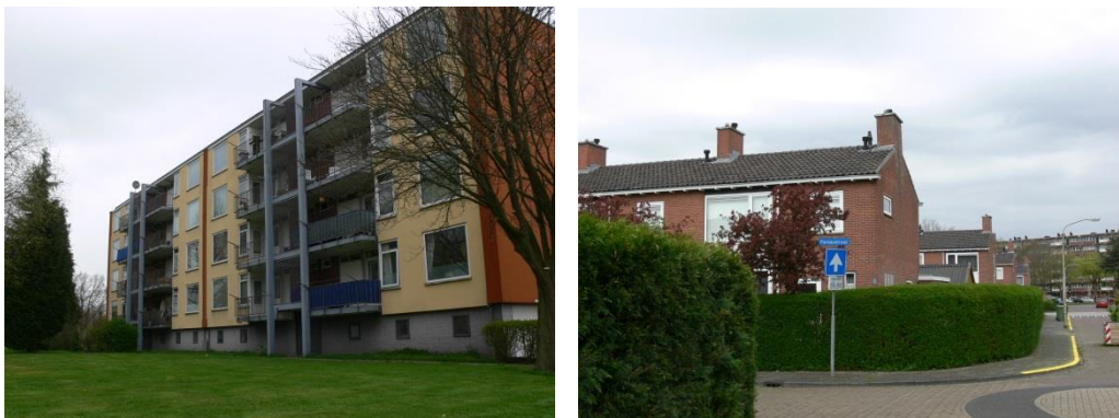
Figuur 2 Impressie van het type bebouwing, waarbij woningen op de foto rechts het meest voorkomend zijn.
