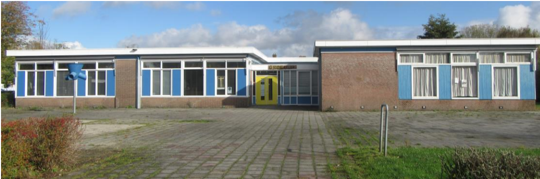
Figuur 18: Zuidwestzijde Vredeveltschool
