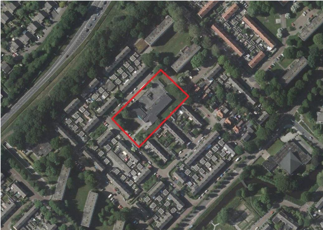
Afbeelding 1. Luchtfoto plangebied (bron: ruimtelijkeplannen.nl, d.d. 29-08-2018)
