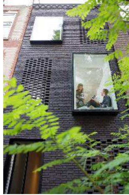
Bloemkozijn aan de gevel
