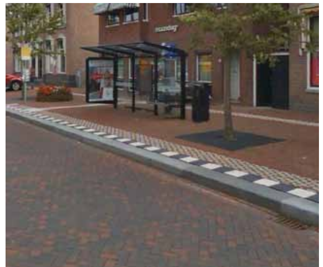
binnenstad Assen: rijloper verdiept uitgevoerd bij het Busstation
