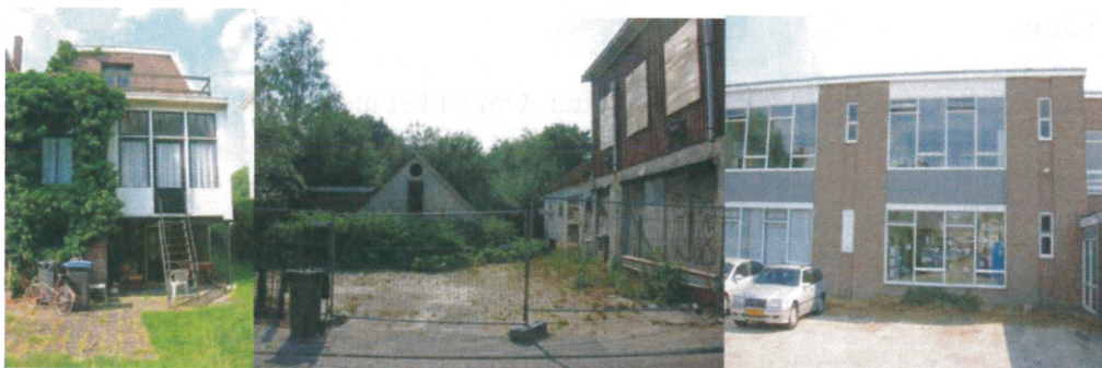
Figuur 1: de drie potentiële verblijfplaatsen van vleermuizen met van links naar recht; de woning aan de vaart zz, de leegstaande panden aan de Gymnasiumstraat en de ventilatiegaten in de muren van de W.A. van Lieflandschool.
