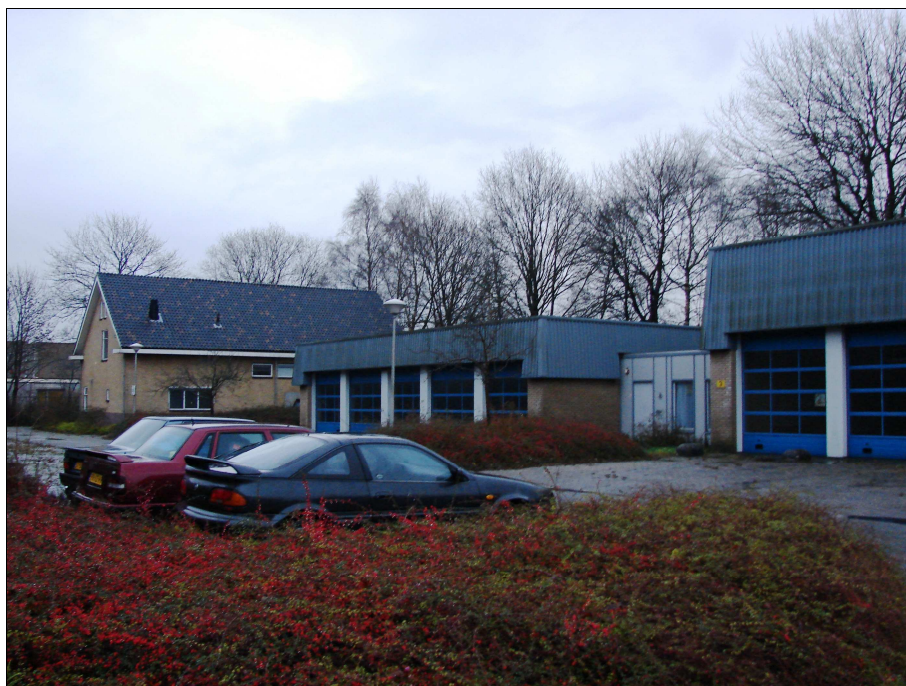
Bijgebouwen marechaussee terrein met zicht op het oosten
