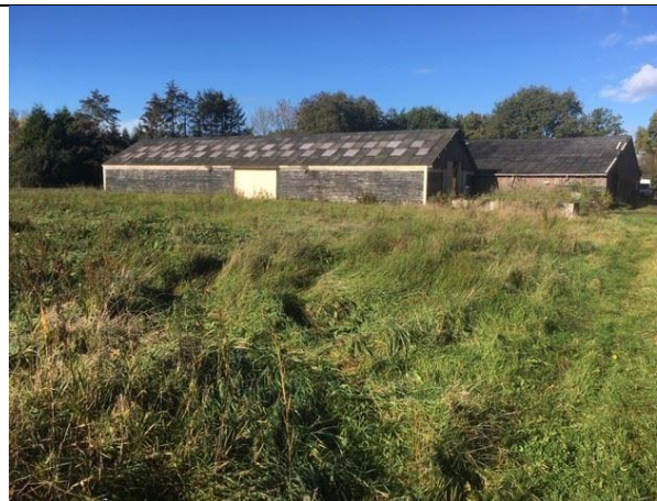
Afbeelding 2.5 aanzicht overkapping en manege vanaf achter gelegen weide (bron: Funda)
