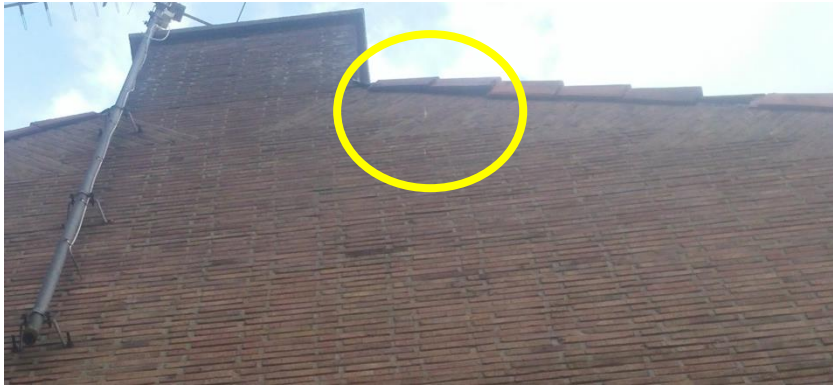
Figuur 4 Ruimte onder de dakpannen voor verblijfplaats gierzwaluw van het schoolgebouw met een mestspoor.
