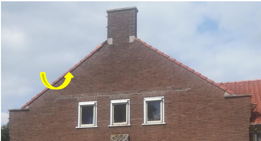
Figuur 5 Toegang voor vleermuizen onder gevelpan van het schoolgebouw.
