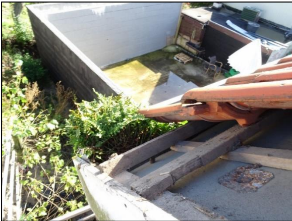
Figuur 11. Positie van de dakpannen en de deklatten op het dakbeschoot.
