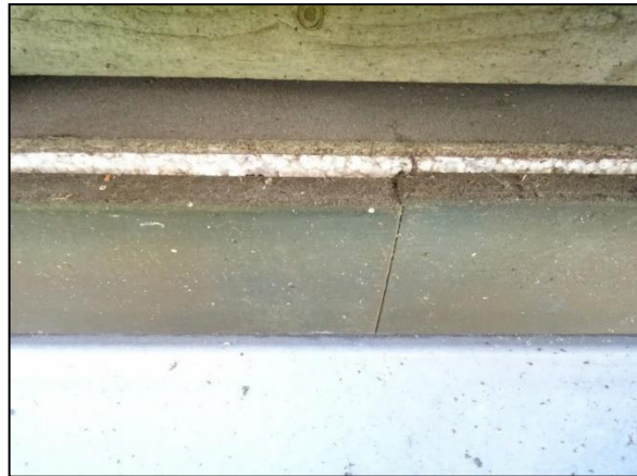
Figuur 12. Overgang van de dakgoot naar het dakbeschoot en de deklatten.
