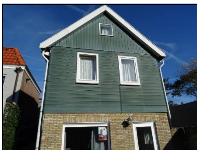
Figuur 3. Zuidzijde van de onderzoekslocatie met betimmering (windveer).
