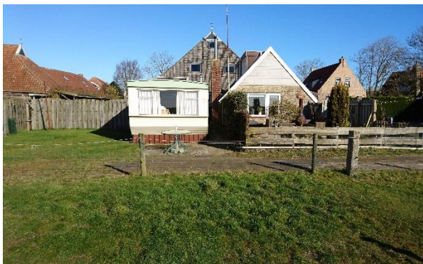
Figuur 2.2: achteraanzicht stacaravan
