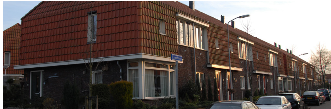
rijen onderling verwant, bijvoorbeeld door middel van pannendaken
