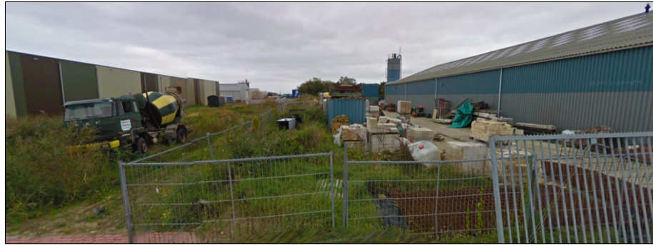
Figuur 4. v.l.n.r. Perceel 3174, tweede toegang op perceel 3173 en opslag op perceel 2795 met de bestaande bedrijfsbebouwing (Google Maps 2010)
