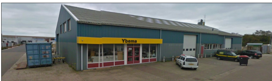
Figuur 3. Bestaand bedrijfsgebouw met winkel aan de Nieuwe Dijk (Google Maps 2010)
