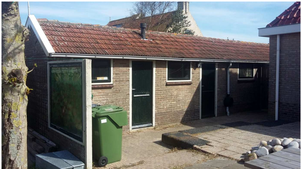
Foto 1. Het te slopen bijgebouw.
