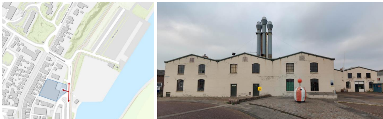
Figuur 1 Situering plangebied (rode pijlen = ontsluitingsroutes Tonnenloods) + screenshot Tonnenloods
