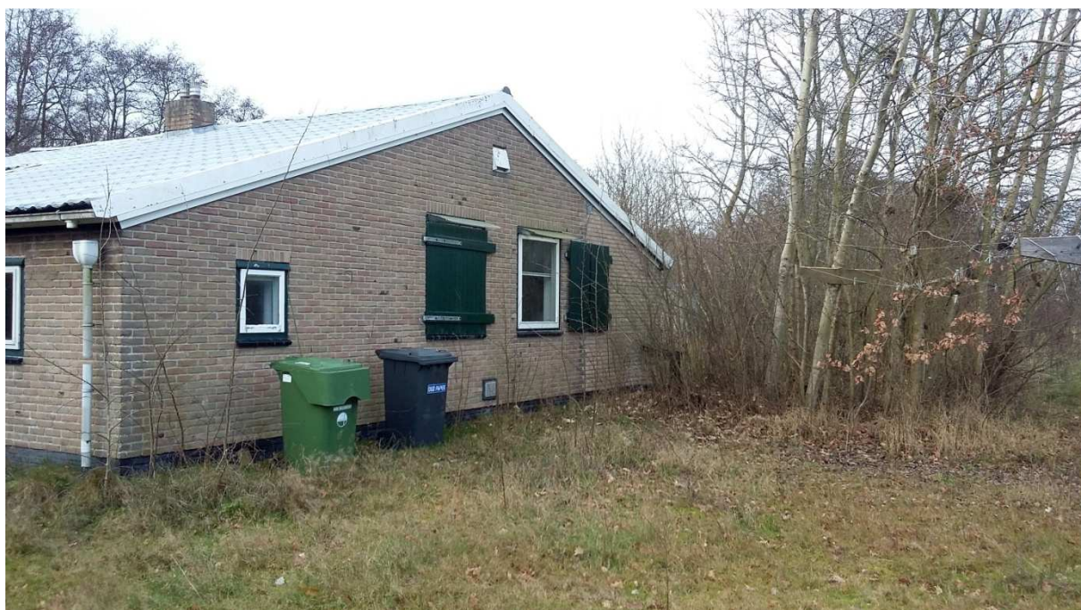
Foto 4. Achterzijde recreatiewoning met bosje.
