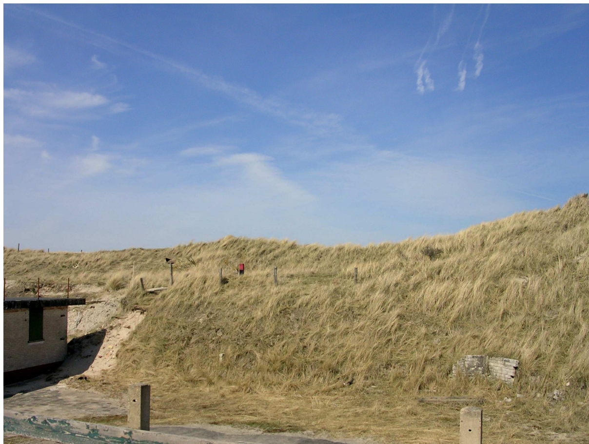
Afbeelding 1: Het bouwvlak (achter de paaltjesrij in de duinen). Op de voorgrond een deel van de opslagbunker.
