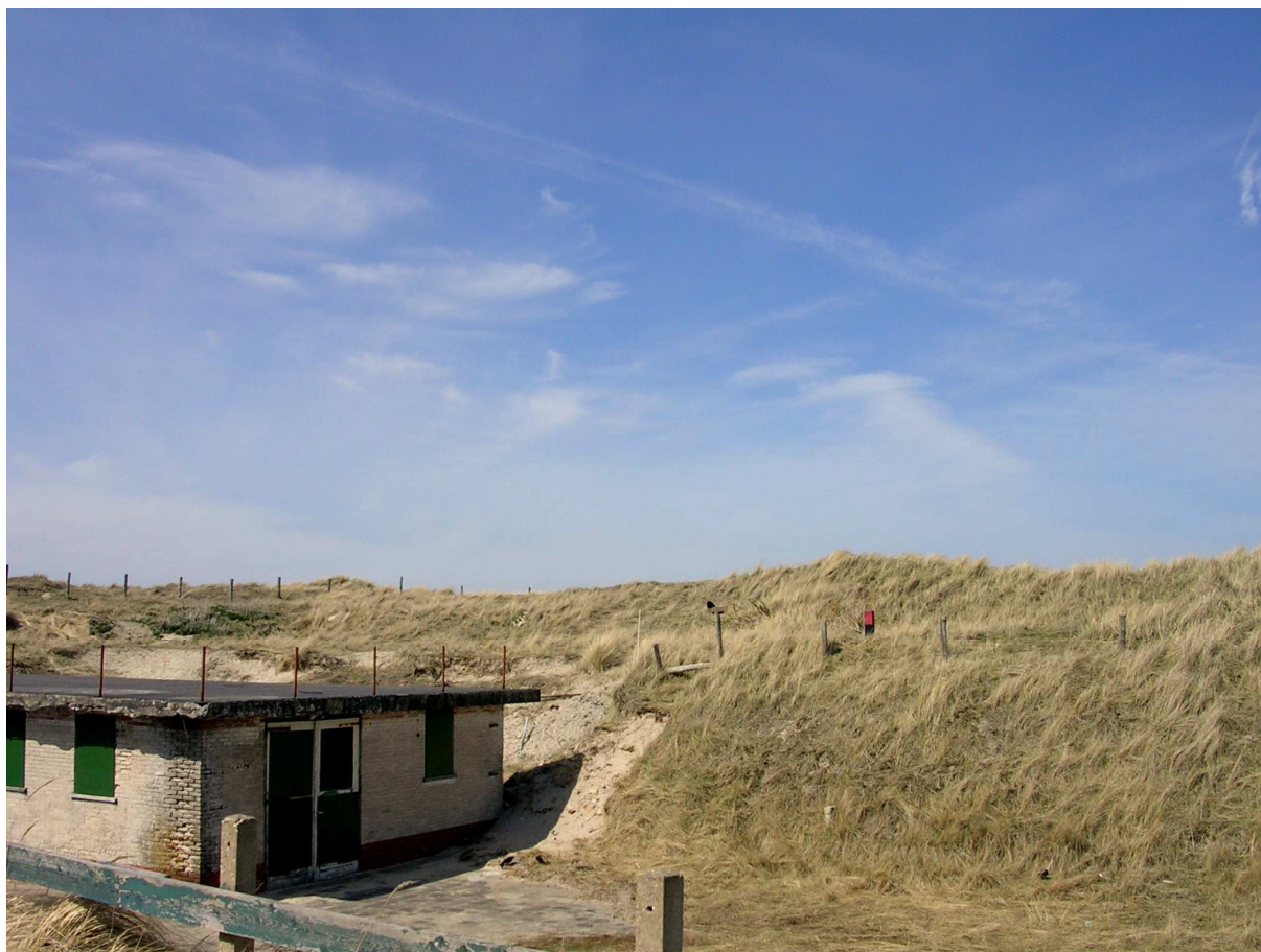
De bouw van een klein hotel in Midsland aan Zee - Terschelling; een ecologische beoordeling.
