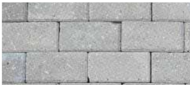
Betonsteen aansluitend op bestaande situatie (grijze stenen voor de terrassen 1 en 2) Parkeerplaatsen d.m.v waterdoorlatende verharding
