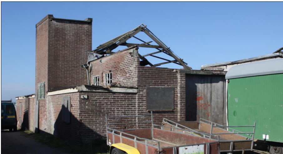
Plangebied gezien vanaf het aangrenzende Seinpaalduin (8 december 2016)
