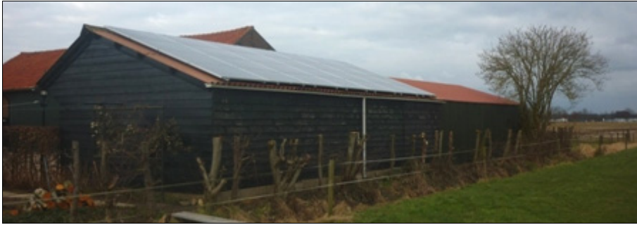
Zonnepanelen op het dak van een donkere schuur
