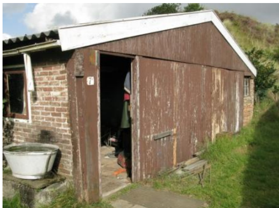
Oude koeienschuur met golfplaten dak (niet geïsoleerd) en enkelwandige muren van hout en steen.
