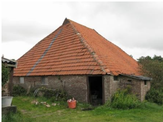
Oude boerderij met pannendak (niet geïsoleerd) en enkelwandige muren
