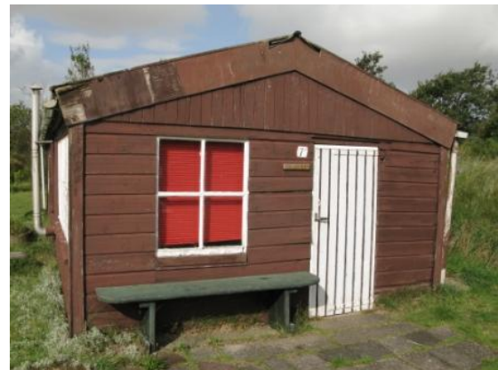
Oude vakantiewoning, opgebouwd uit enkelwandige houten wanden en een slecht geïsoleerd dak.
