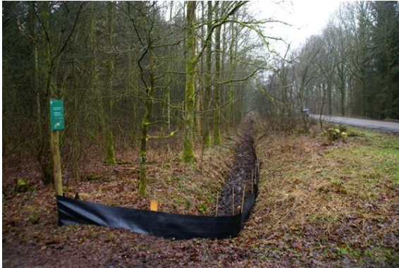
Figuur 4 Voorbeeld foliescherm. Voor bevestiging kan men het beste piketpaaltjes gebruiken. Gebruik geen anti-worteldoek, want die biedt houvast voor hagedissen, die er vervolgens overheen klimmen.
