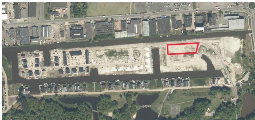
Figuur 2.1 Luchtfoto bestaande situatie
