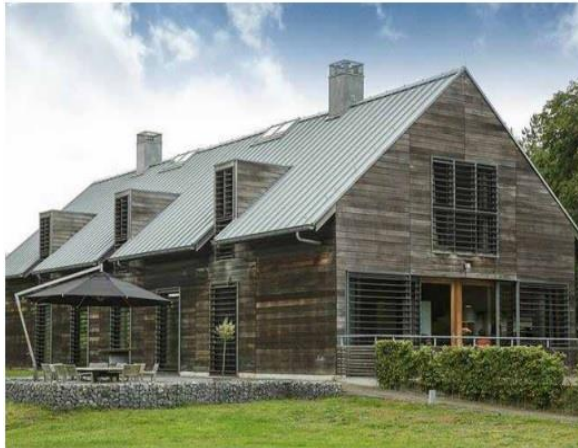
referentiebeeld: eenduidig bouwvolume met zadeldak en ondergeschikte dakkapellen
