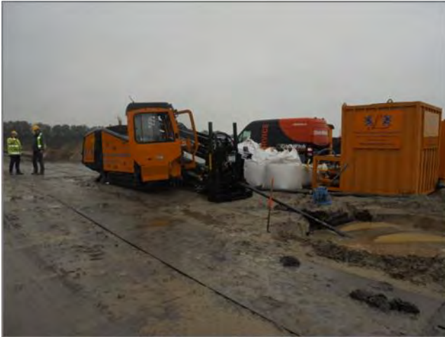
Figuur 4: Booropstelling ten behoeve van een gestuurde boring.
