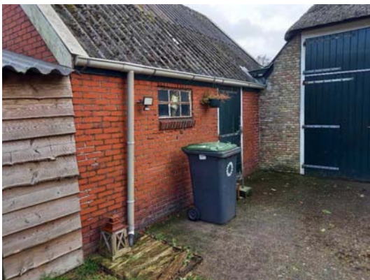
Foto 5 & 6: intacte dakgoot en beschadigde dakgoot (dak C)
