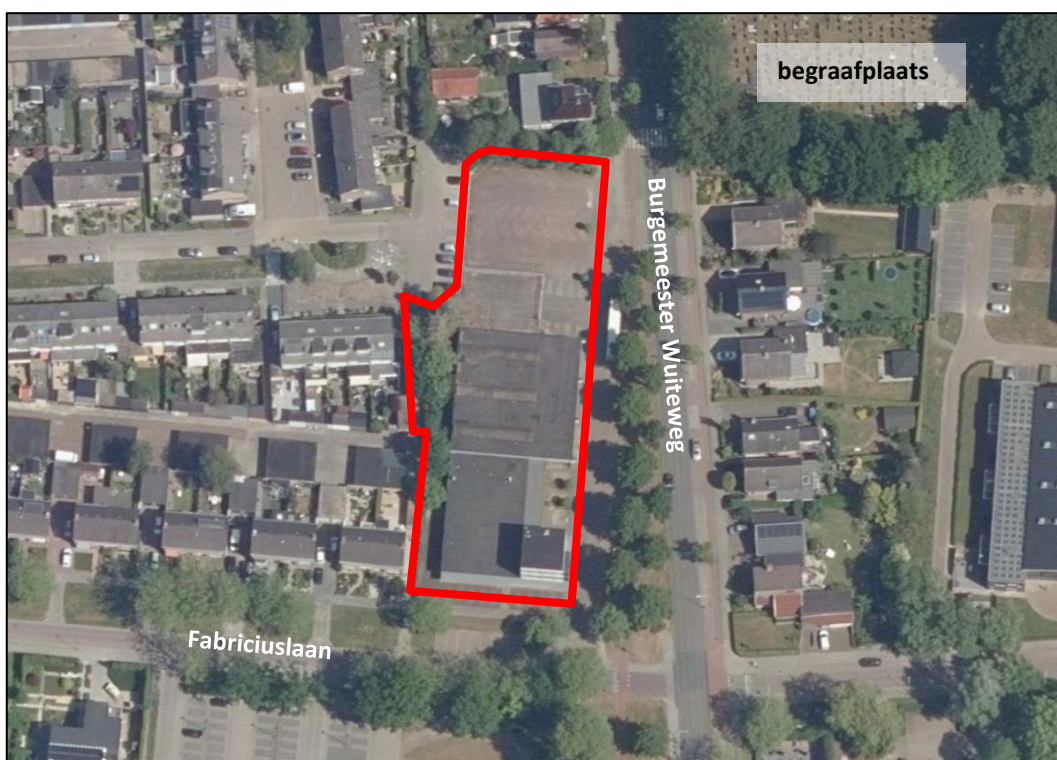
Figuur 2.1 Luchtfoto plangebied (vóór de sloop van de gebouwen)
