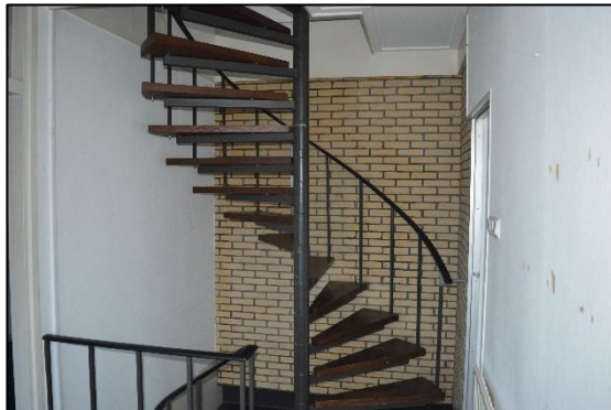
Afbeelding 2.8. Wenteltrap die appartement op eerste en tweede verdieping met elkaar verbindt.
