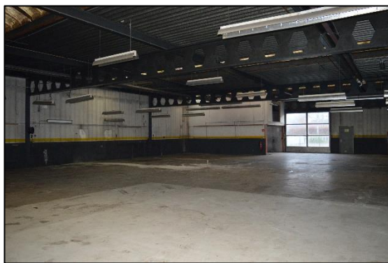
Afbeelding 2.10. Werkplaats voormalige ABD locatie.
