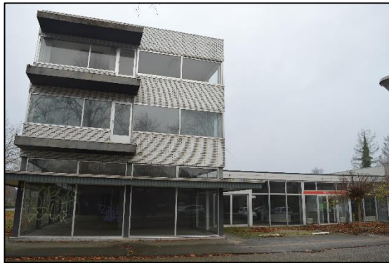
Afbeelding 2.2. Voorzijde pand met appartementen, gezien vanaf oosten.
