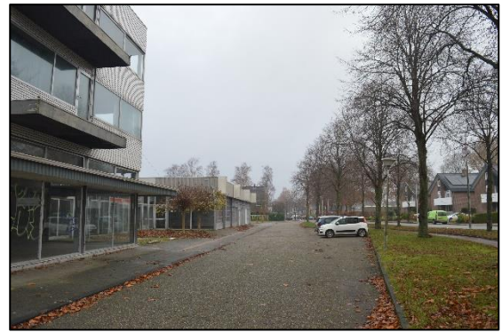
Afbeelding 2.15. Doorgaande weg en parkeerplaatsen voor pand, gezien vanaf zuiden.
