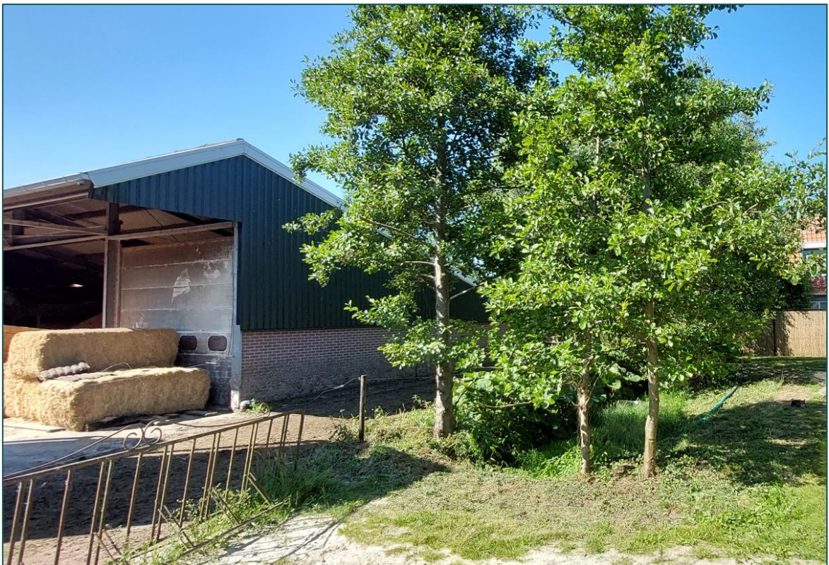
Figuur 4 De agrarische schuur welke uitgebreid zal worden tot waar de bomen staan.
