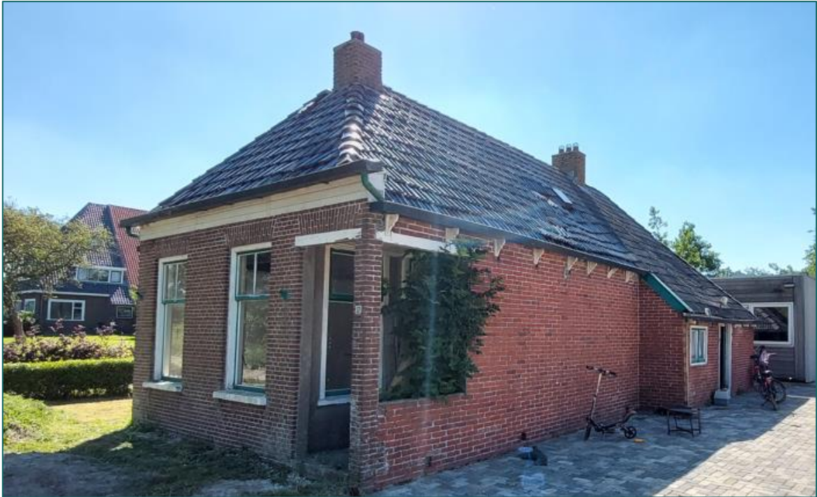
Figuur 1.3 Op de planlocatie is men voornemens om de leegstaande woning te slopen.
