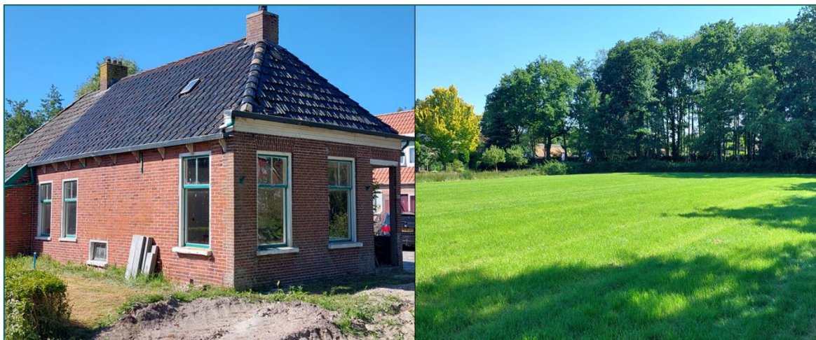
Figuur 1.1 De te slopen woning is gelegen aan de Fallaetswei 17 (links) en de locatie van de nieuwbouw is gelegen aan de Fallaetswei 12a (rechts) te Drachtstercompagnie.
