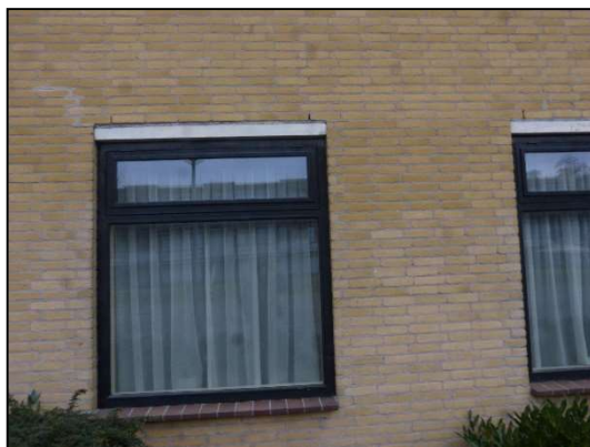
Afbeelding 2.6. Ramen met open stootvoegen aan de oostzijde.
