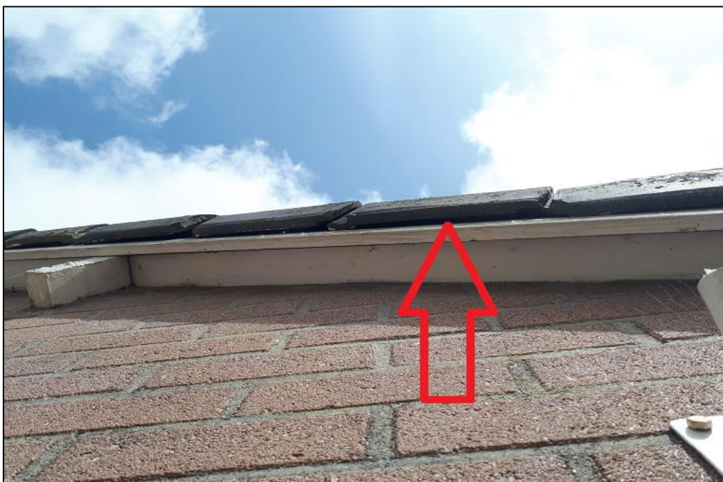
Figuur 3.2.: Ook in het clubgebouwtje zijn potentiële verblijfplaatsen van vleermuizen aanwezig.
