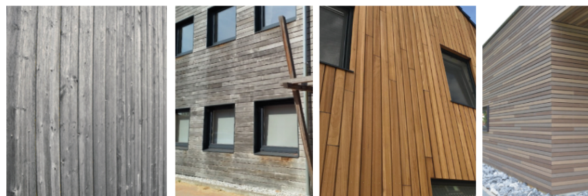
7. vergrijsd hout als gevelbekleding
