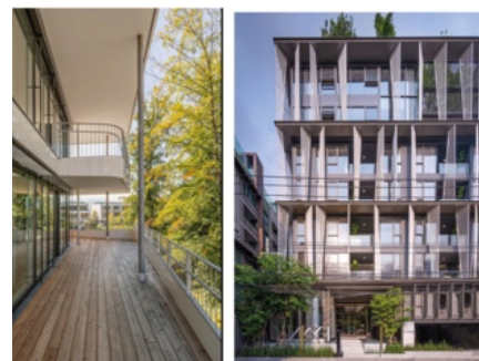
11. royale inpandige balkons / veel diepte in gevel
