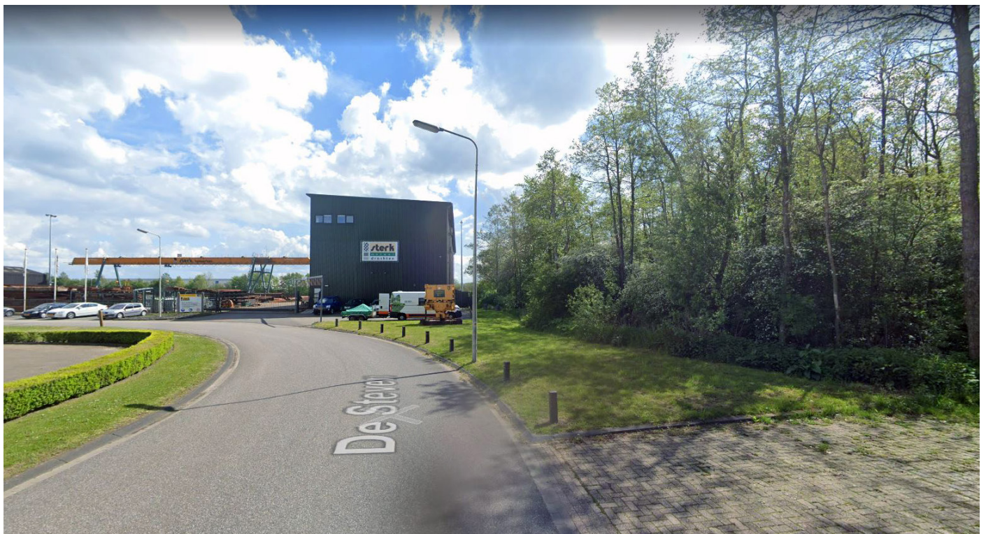
Fig 5. Zicht op Sterk Heiwerken (en de Lashal) vanaf De Steven (bron: Sterk Heiwerken)
