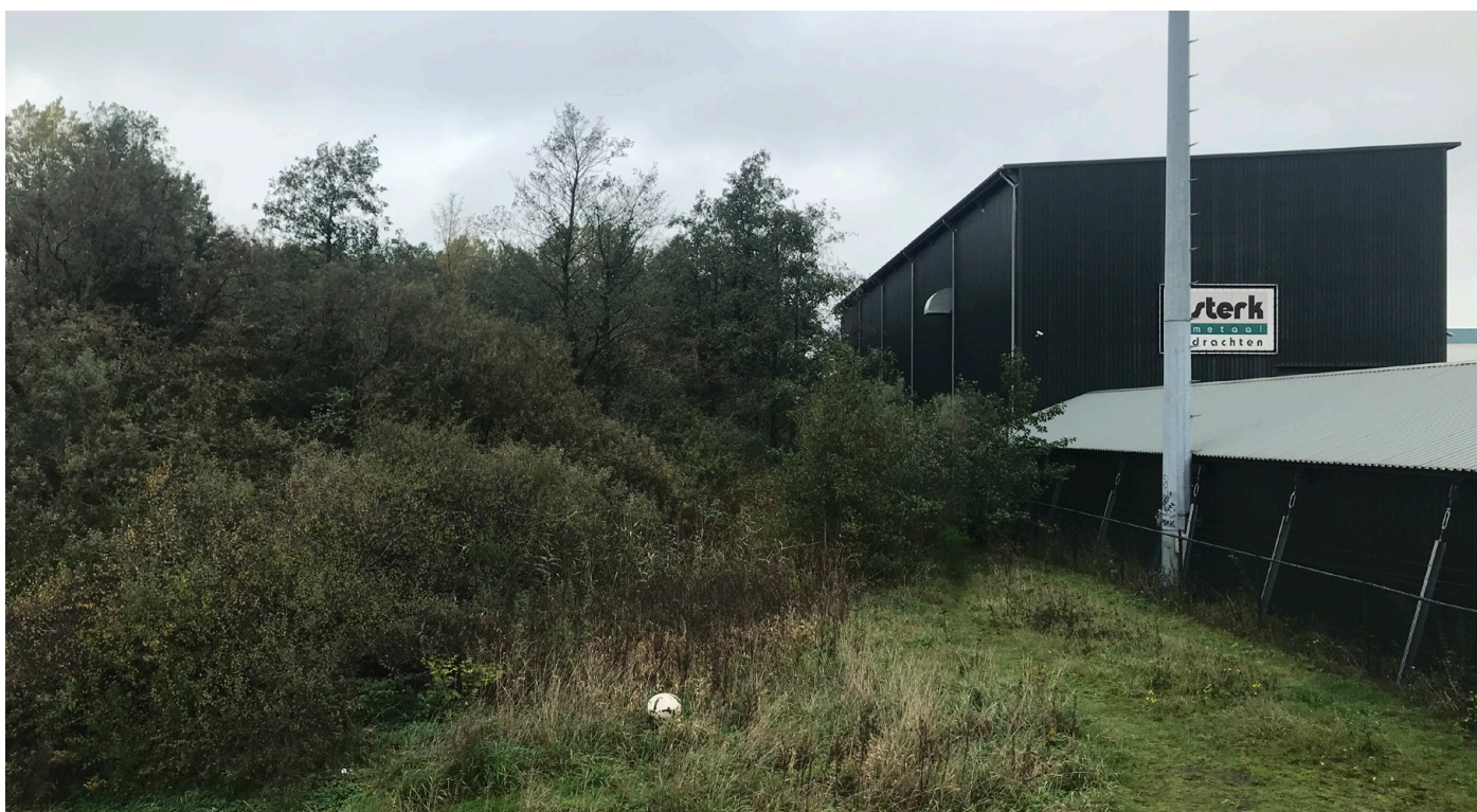
Fig 3. Zicht op de Lashal (gezien vanaf zuidzijde groenstrook) (bron: Sterk Heiwerken)
