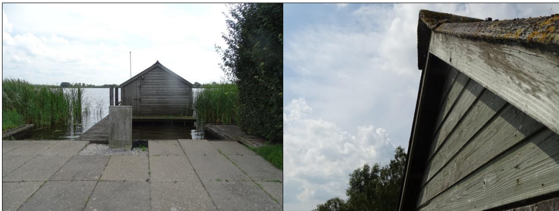
Foto 1 en 2. Impressie van het plangebied op 19 augustus 2020. Links het aanzicht op de noordzijde van het te slopen schiphuis vanuit het noorden. Rechts de zuidelijke nok van het dak van het schiphuis vanuit het zuidoosten.
