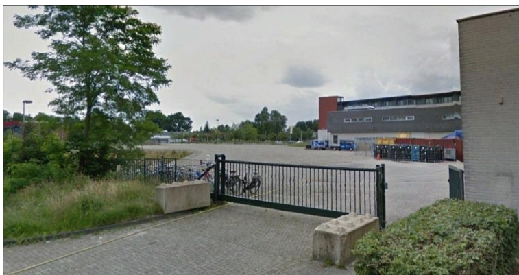
Figuur 3. Voormalig busstation vanaf de Ratelwacht met entree voor de distributielogistiek
