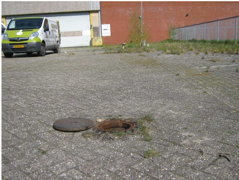
Parkeerterrein met mangat ondergrondse dieseltank (60 m 3 )
