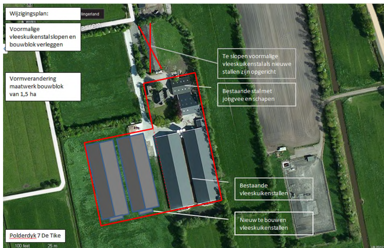
Foto inrichting Polderdyk 7 met daarop de nieuw te bouwen pluimveestallen principebesluit 15-2-2015
