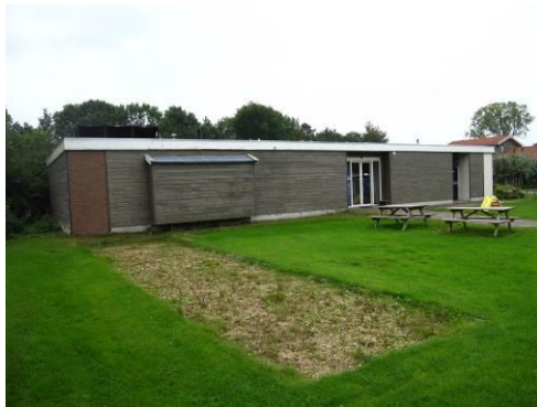
Gebouw met receptie en doucheruimten/toiletten
