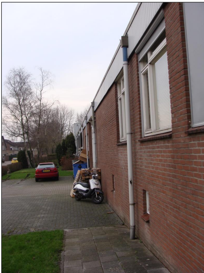
Figuur 3. Zuidzijde van het pand.
