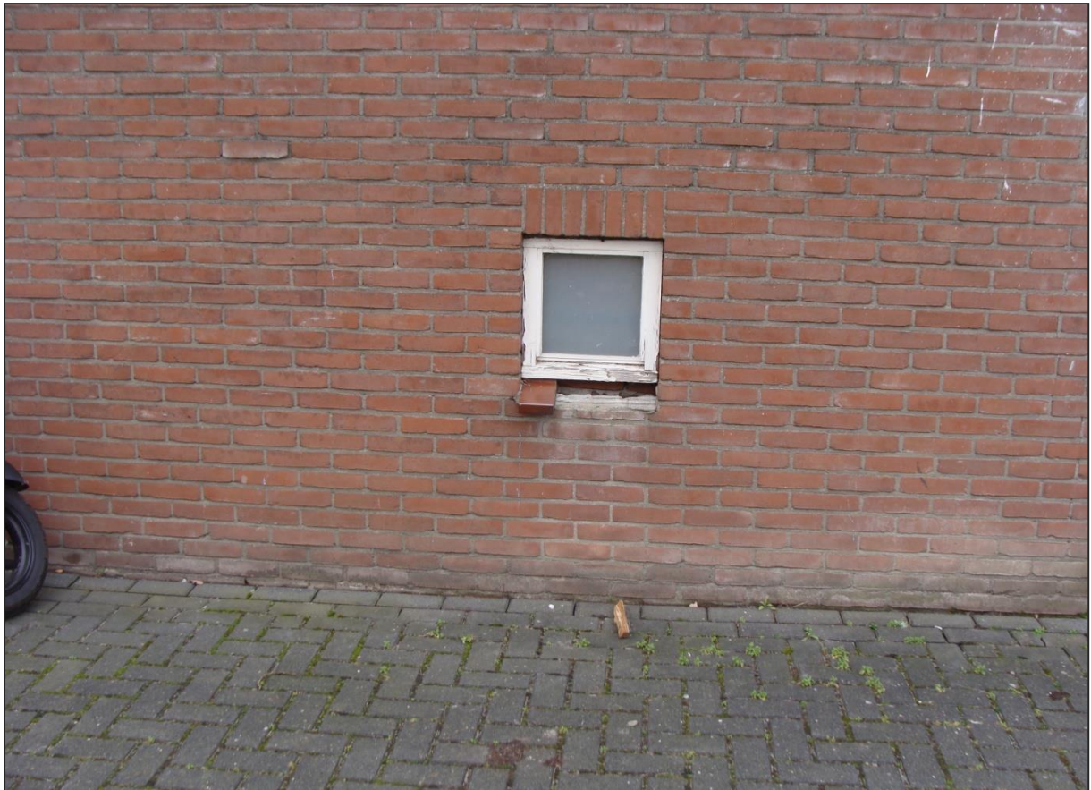
Figuur 4. Het gebouw beschikt over een open spouwmuur, onder andere zichtbaar langs de onderzijde van dit raam een de zuidzijde.
