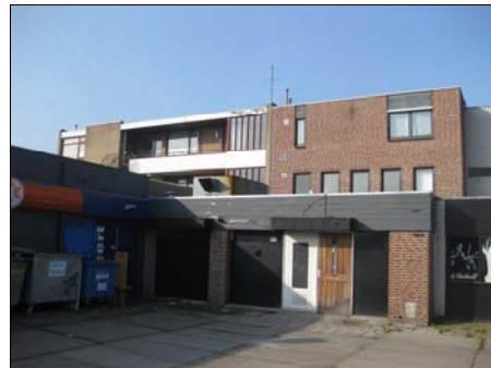
Achterkant elektronica- en wit- goedwinkel met uitbouw
