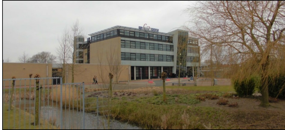
Aanzicht schoolgebouw vanuit het oosten (20 maart 2013)
