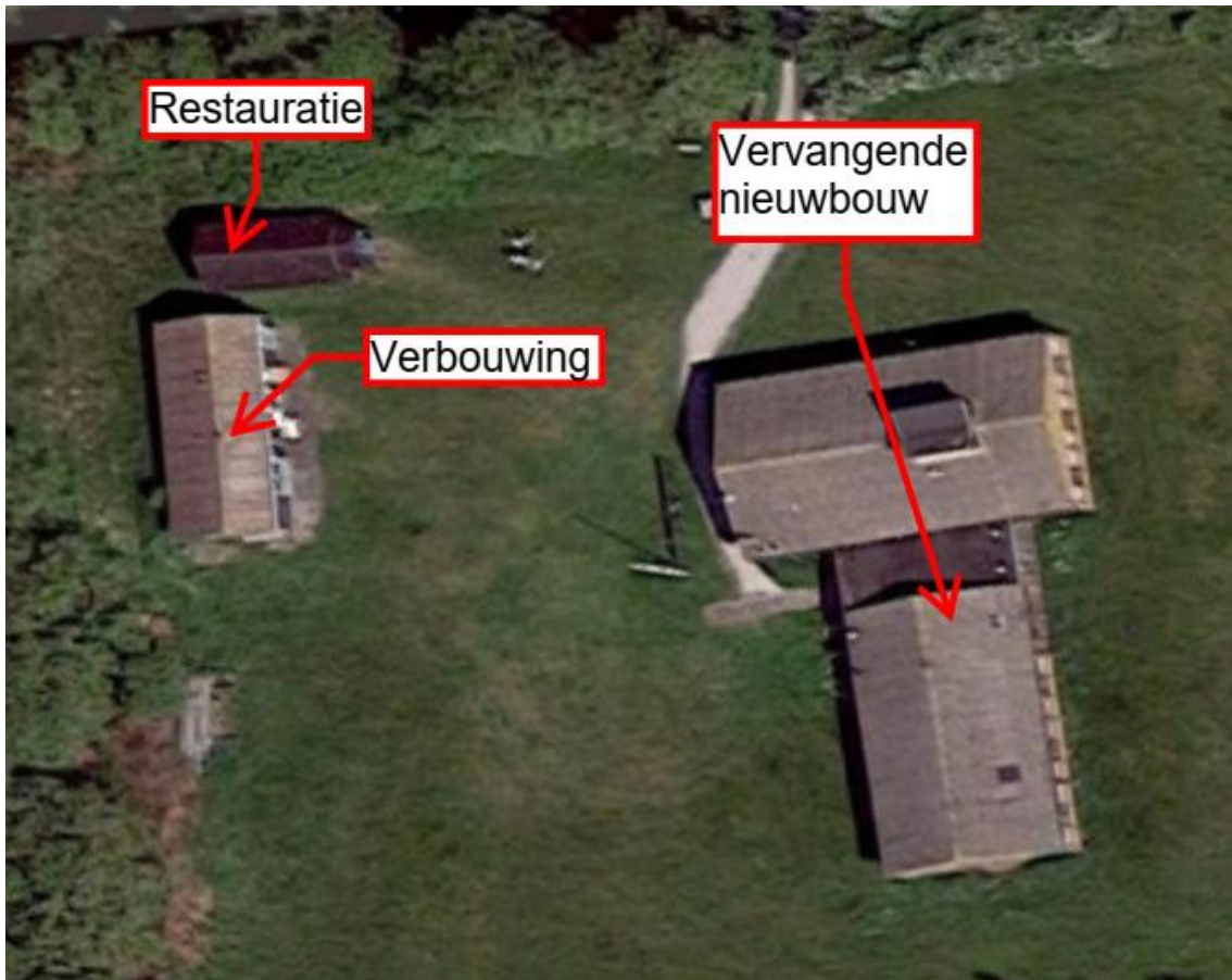
Figuur 1. Indicatie van de werkzaamheden
