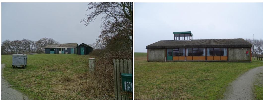
Foto 1 en 2. Impressie van het projectgebied gezien vanaf de ingang op 21 februari 2019, met werkschuur en kleine herdershut (links) en de grote Herdershut (rechts)
